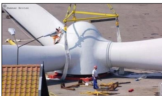
Figura 4. Montaje del Rotor de Horns Rev 2
